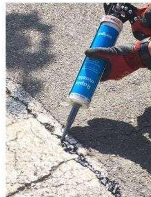
**Caractéristiques principales:** Le RAPID-MASTIC est composé de bitume, de résines élastomères pour le remplissage et le colmatage de fissures, présenté sous forme de cartouche de 310 ml, prêt à être appliqué avec un simple pistolet applicateur, totalement à froid.
